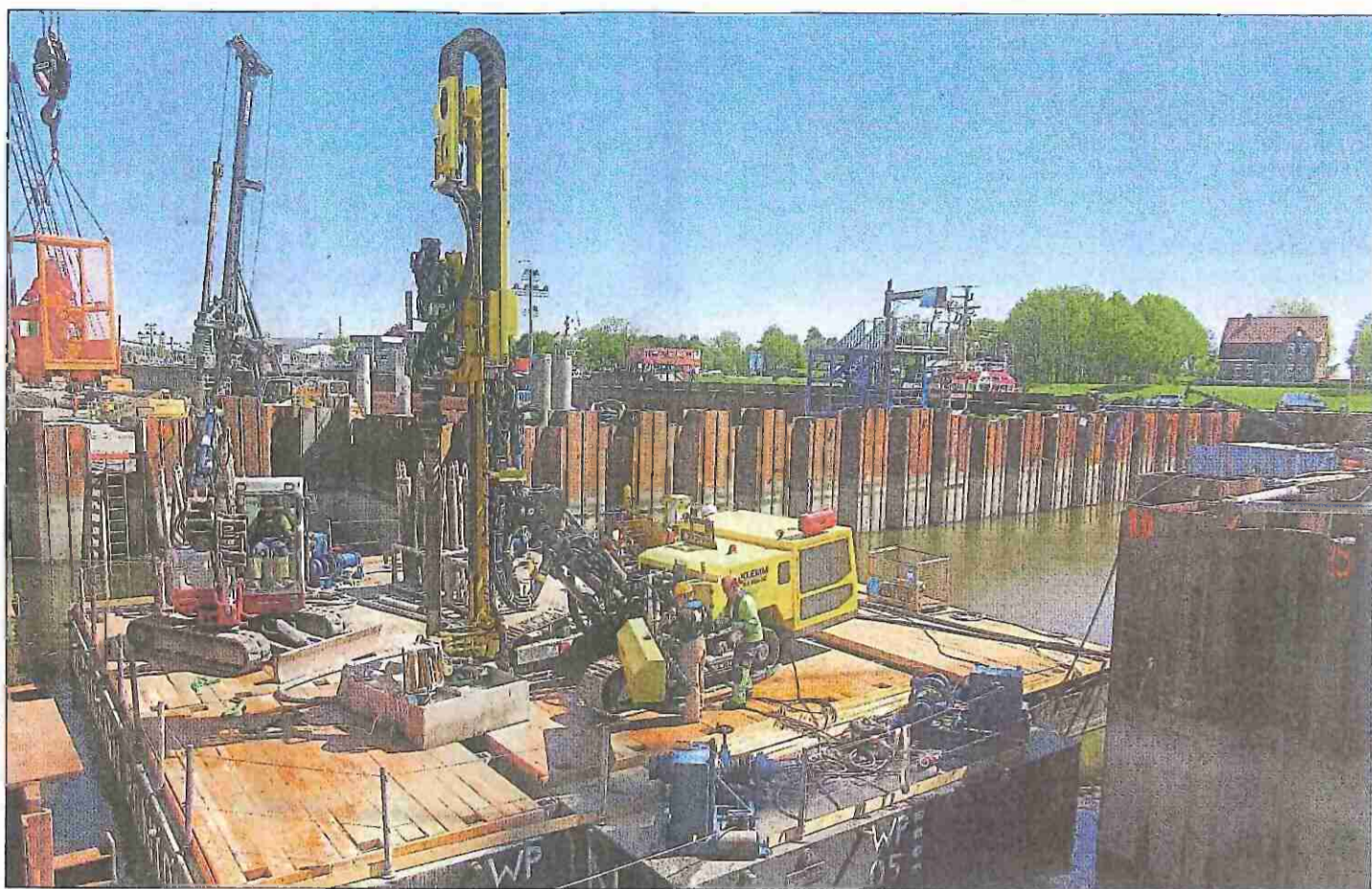
Das Foto zeigt die Bohrungen für die Verankerung der Betonsohle in der Baugrube der Torkammer.
