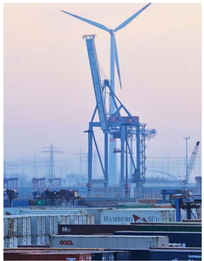
Abb. 57: Windenergieanlagen im Hamburger Hafen
