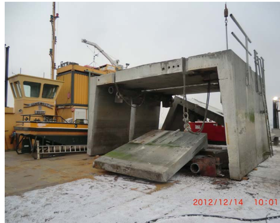
Abb.18 ... und lagert auf der „Annegret“ zwischen.
