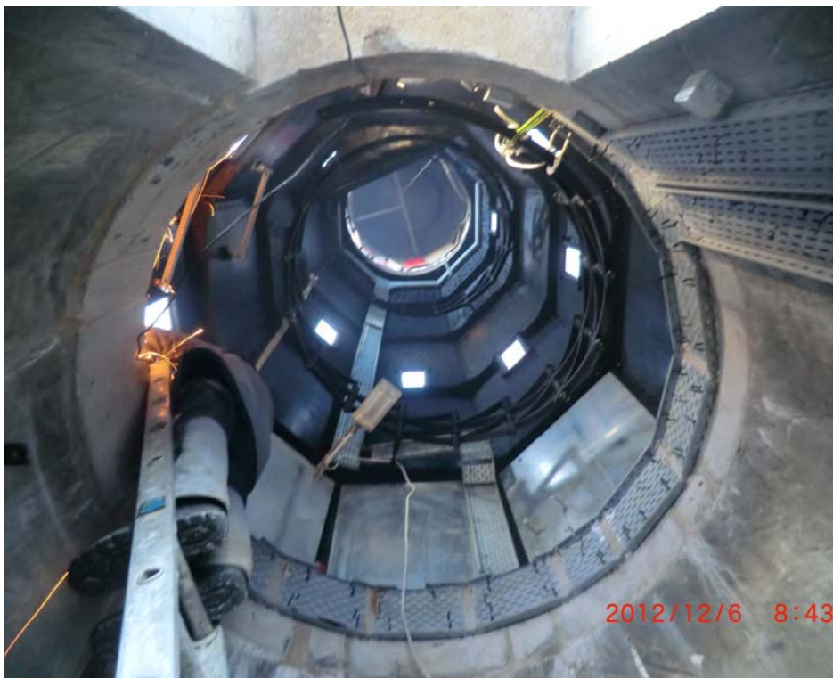
Abb.9 Lösen der Verankerungen vom Sockel im Turm
