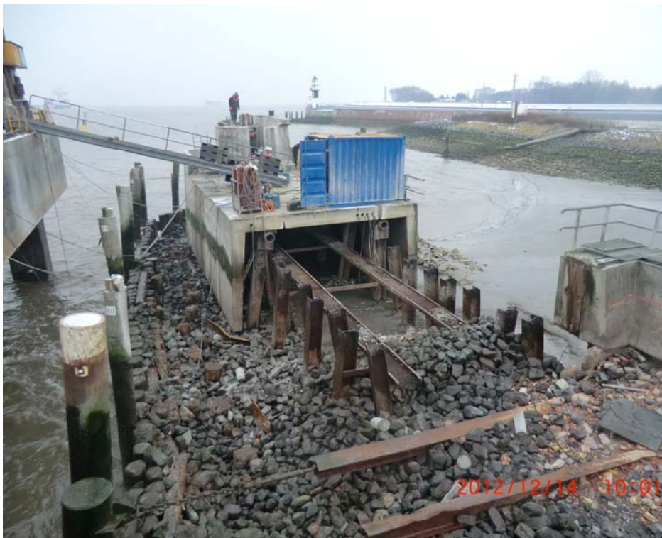
Abb.17 Das erste Element ist nun zurückgebaut ...
