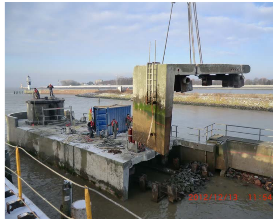
Abb.16 ... konnte, beginnend mit dem ersten Drittel, das östliche Überbauelement weggehoben werden.
