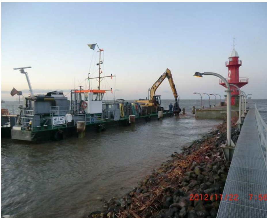
Abb.1 Der Bagger wird in Position gefahren
