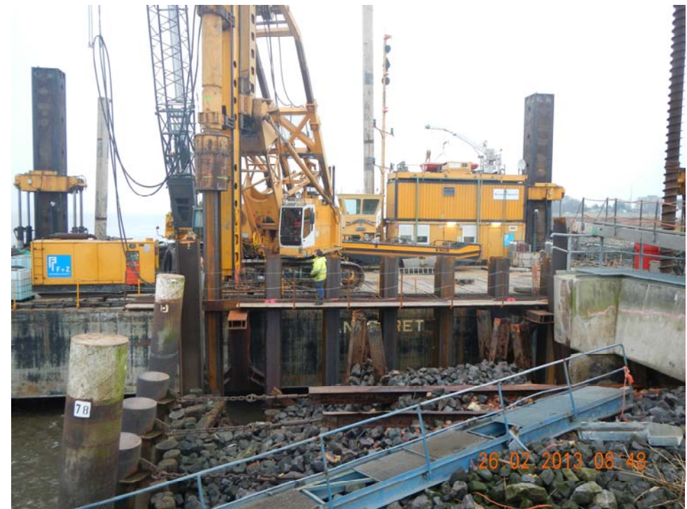
Abb.31 Die Hubinsel wurde bei Niedrigwasser auf erforderliche Höhe gesenkt. So können die Tragbohlen, geführt, auf Solltiefe von -21,5mNHN gerammt werden.
