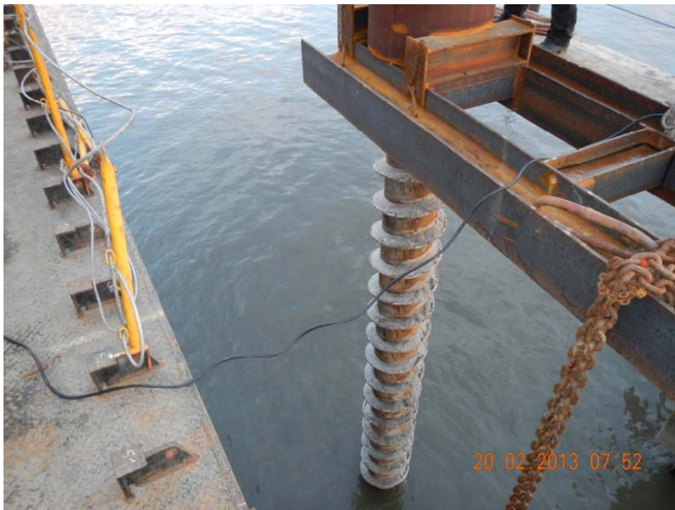
Abb.23 Die Bohrschncke in der Rammführung
