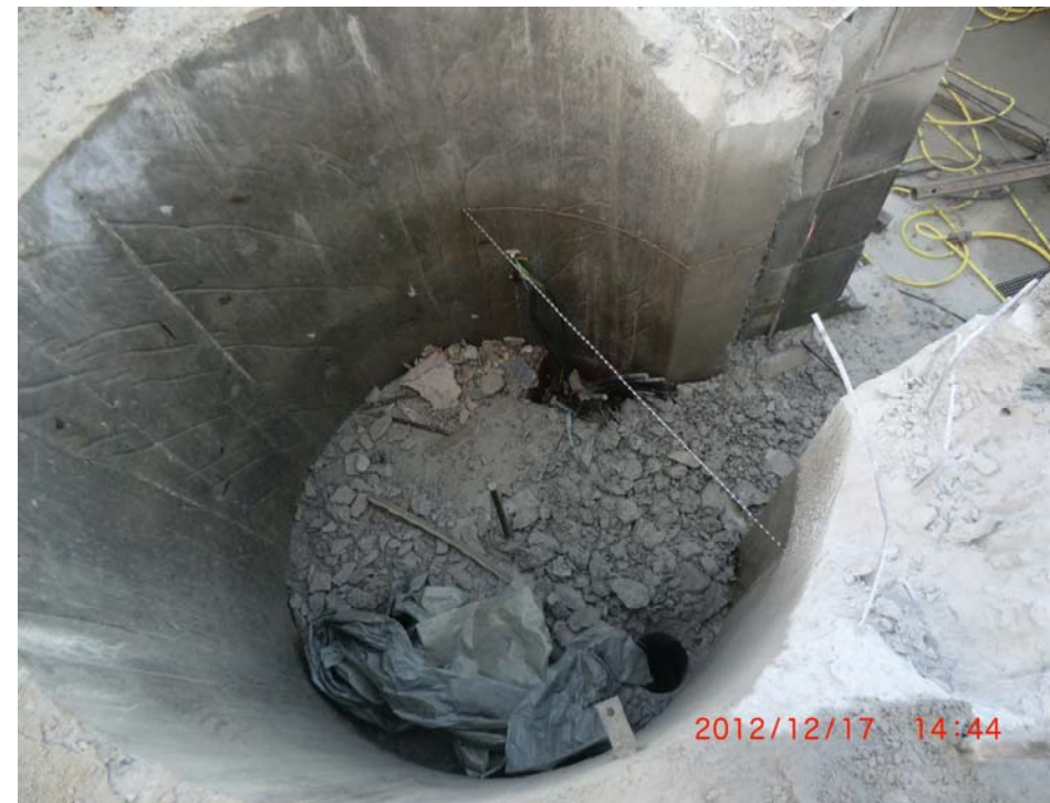
Abb.2 ... sucht sich das Sägeband, durch die Fugen, den Weg des geringsten Widerstandes
