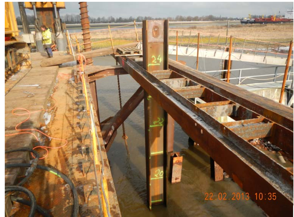
Abb.26 ... und zunächst bis auf Höhe der Führung in den Baugrund gerammt.
