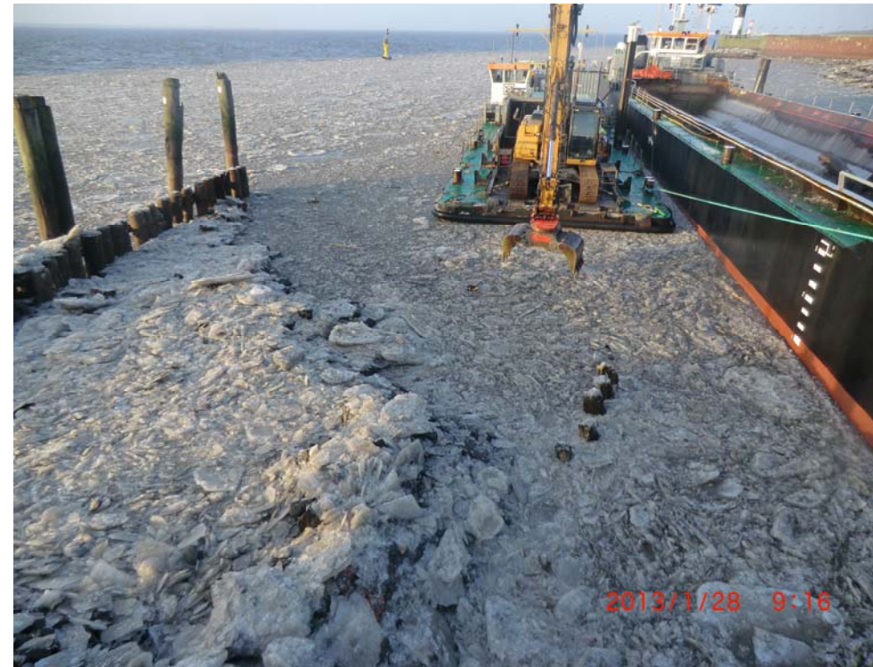
Abb.16 ...Holzfaschinen/-rost/-gründung abgebrochen und auf eine Schute verladen.
