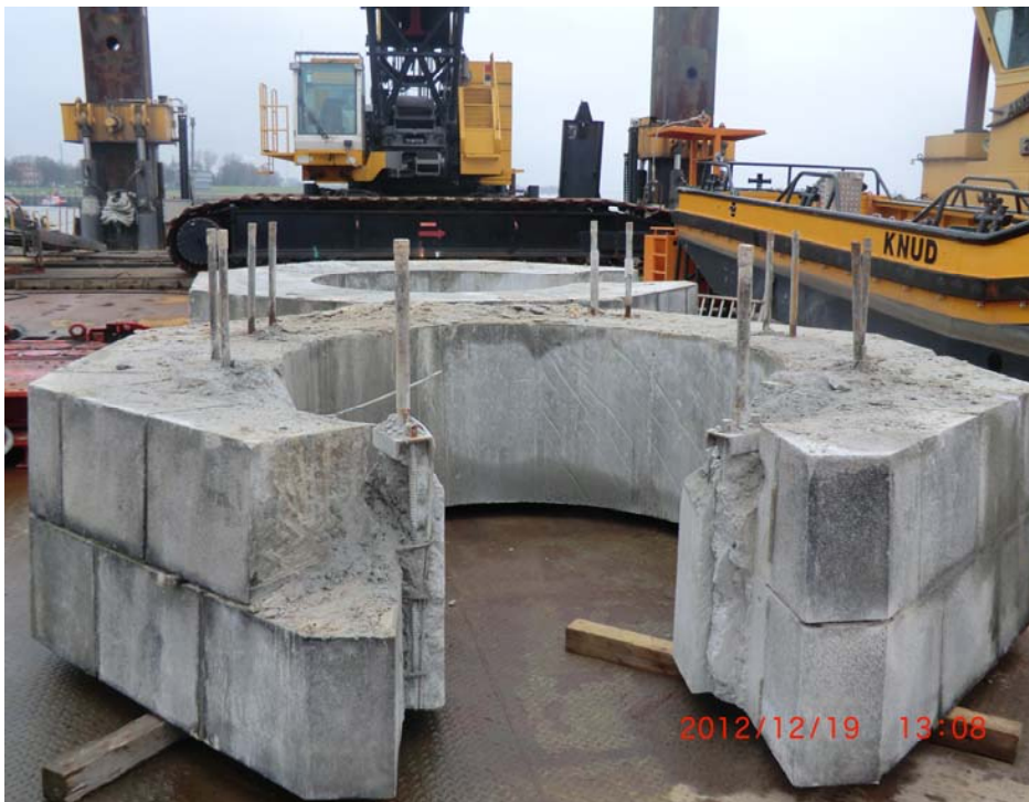
Abb.3 Der zersägte Sockel auf der Hubinsel
