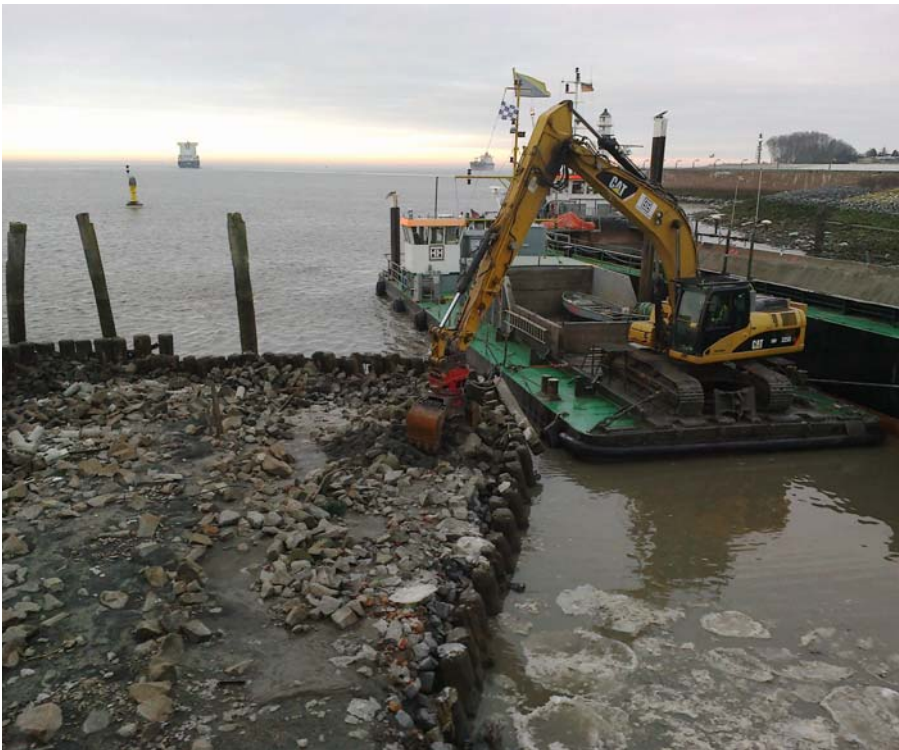
Abb.15 Restliches Deckwerk wird aufgenommen, ...
