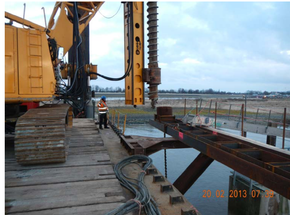
Abb.22 Mit der mäklergeführten Bohrschnecke werden Erkundungs- und Räumungsbohrungen durchgeführt.
