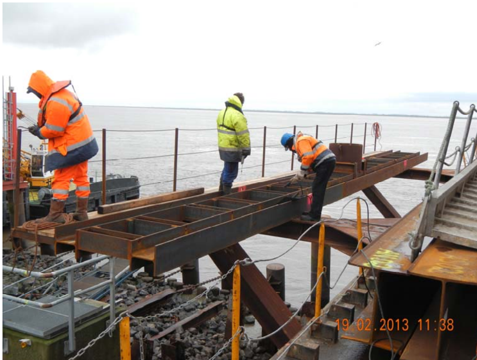
Abb.21 Die Rammführung der Schottwand wurde auf zwei Konsolen gehievt, auf die geplante Achse eingemessen und fixiert.
