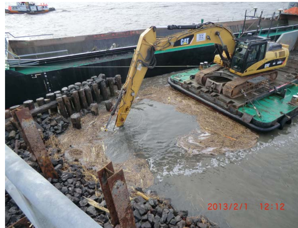
Abb.18 Noch einige Holzpfähle und der alte Molenkopf ist Geschichte.
