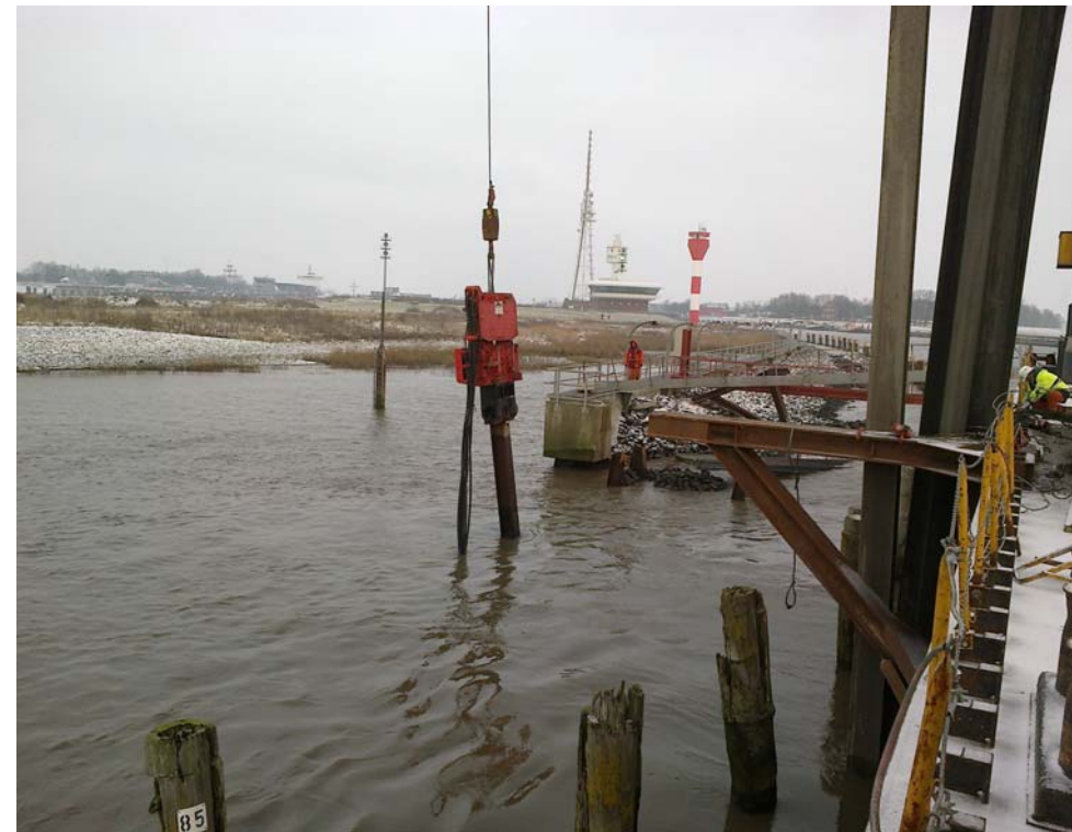
Abb.12 Mit dem Rüttler zieht der Kran schließlich den letzten Pfahl aus dem Faschinendamm.
