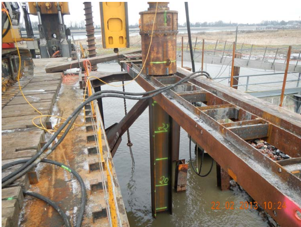
Abb.25 Nach den Bohrungen wurde die erste Tragbohle der Schottwand eingebracht ...
