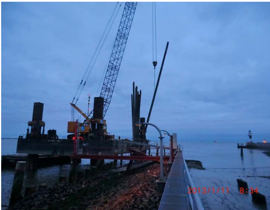
Abb.9 Beim Verladen bereits gezogener Trägerpfähle
