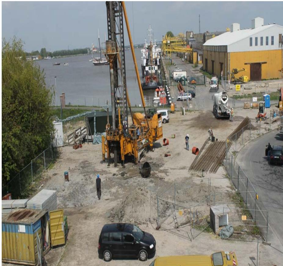
Abb. 3: Bohren der Gründungspfähle
