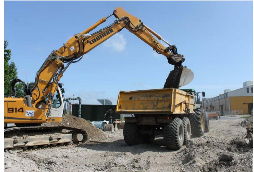
Abb.6: Abtransport des Aushubes
